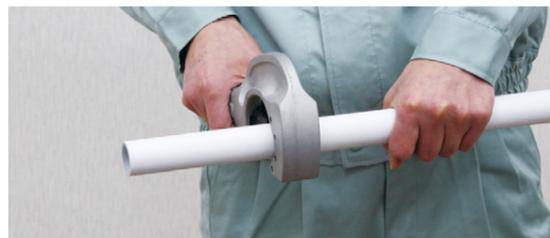
② 専用工具を使用して必要な長さにパイプをカットします。
