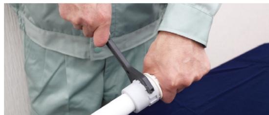
⑥ 袋ナットを緩み防止機構の切れ込みまでしっかりと締め付けます。
