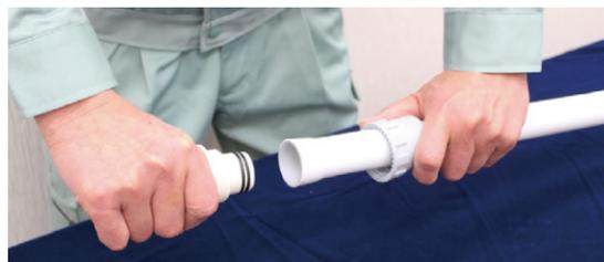
⑤ 専用継手のニップルを拡管されたパイプに挿入します。
